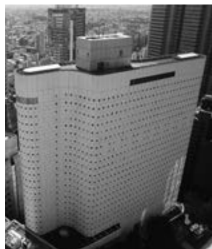
新宿ワシントンホテル本館
