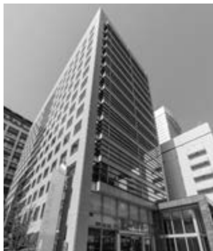
大宮センタービル
