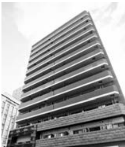
S-RESIDENCE神戸磯上通
