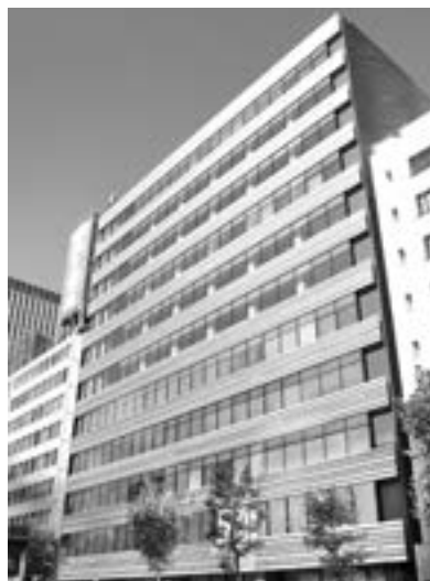
ヒューリック虎ノ門ビル
