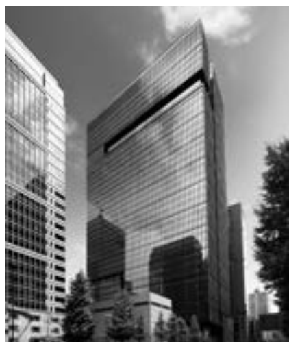
大手町タワー (底地)
