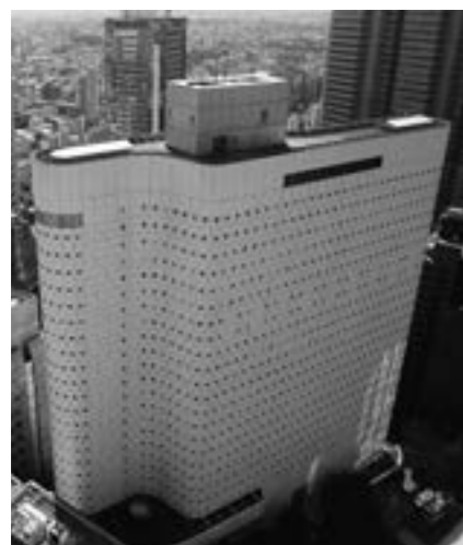
新宿ワシントンホテル本館
