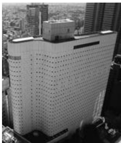
新宿ワシントンホテル本館
