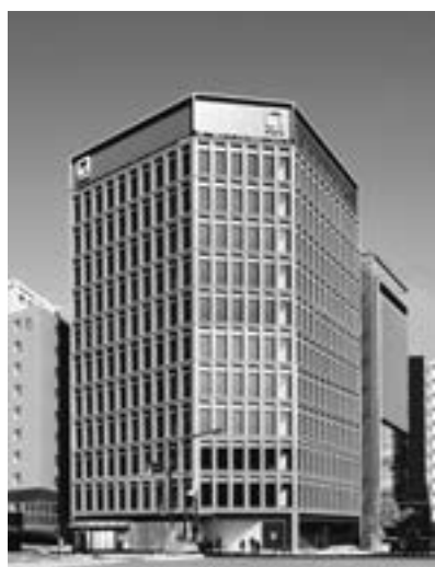
S-GATE日本橋本町
