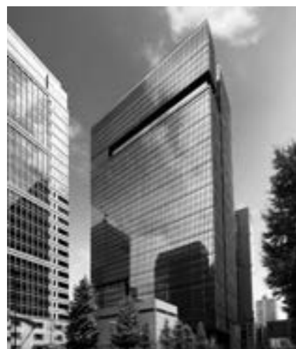
大手町タワー(底地)
