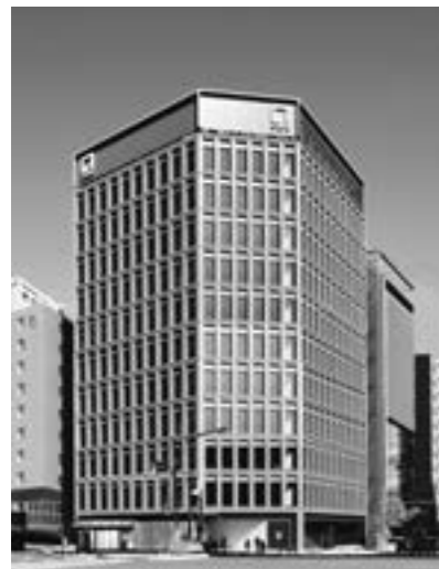
S-GATE日本橋本町
