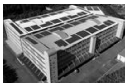
いなペロジスティクスセンター
